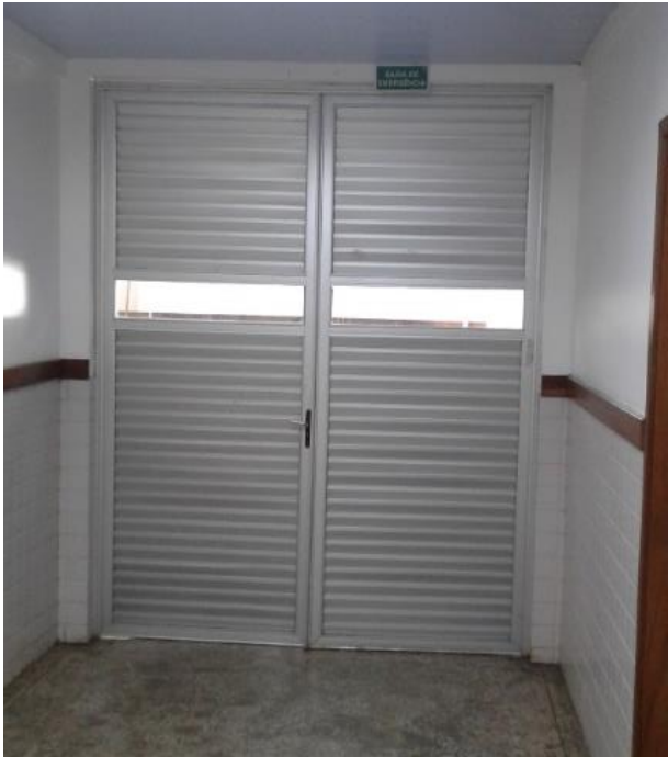
Figura 5 – Saída de emergência localizada na parte dos fundos da instituição
