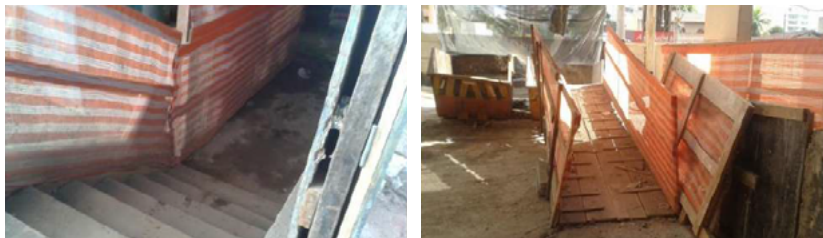
Figura 3 – Escadas e rampas provisórias de madeira utilizadas no acesso interno da obra
