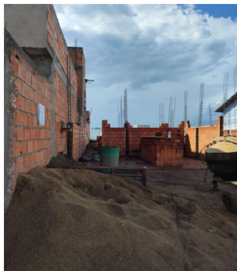
Figura 2 – Vista geral da obra residencial de pequeno porte analisada
