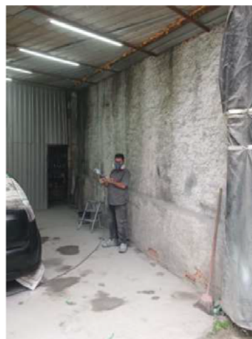
Figura 3 – Irregularidades na pintura
