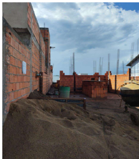
Figura 3 – Vista geral da obra residencial de pequeno porte analisada
