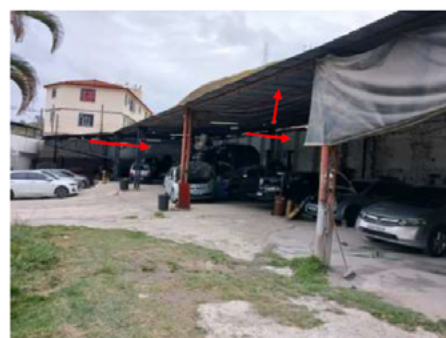
Figura 6 – Irregularidades na ventilação
