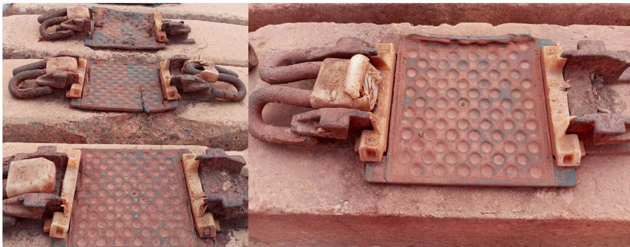
Figura 5 - Palmilhas fixadas nos dormentes de concreto reutilizados
