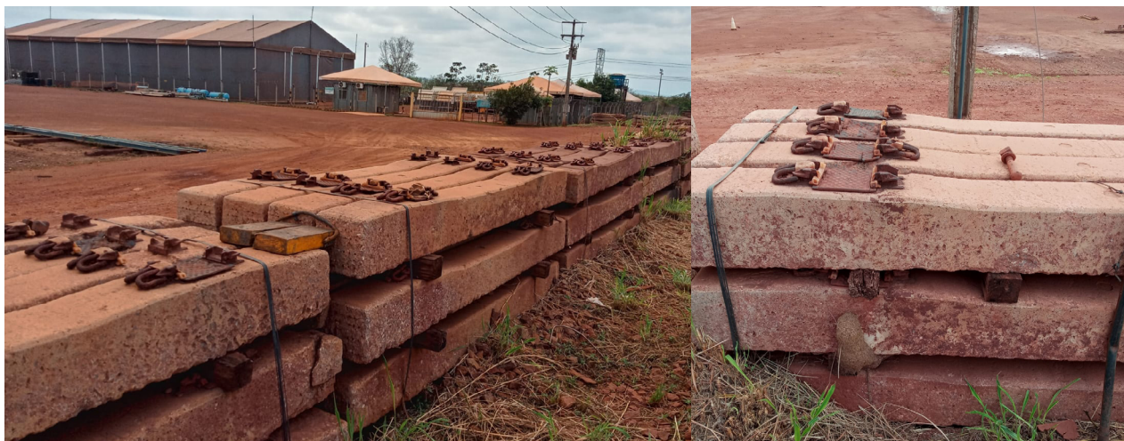
Figura 4 - Reaproveitamento de dormentes usados de concreto como muros de contenção
