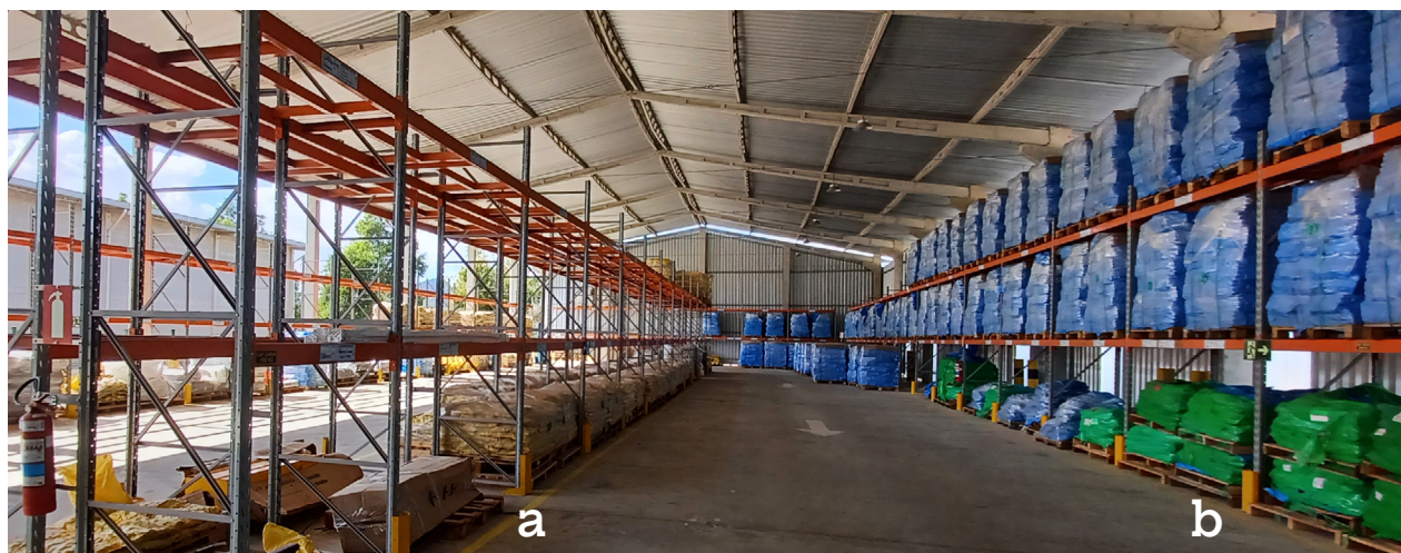
Figura 12 - Pavilhão de armazenamento de materiais novos, sendo (a) lado sem parede de proteção aos raios solares e (b) lado com proteção ao intemperismo
