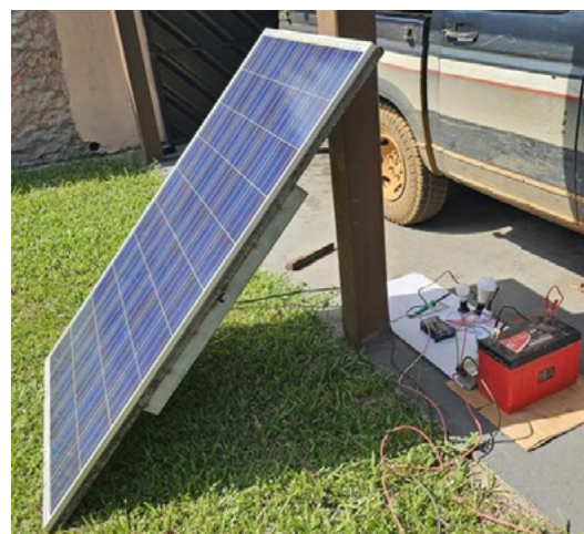
Figura 16 - Montagem da estrutura do teste
