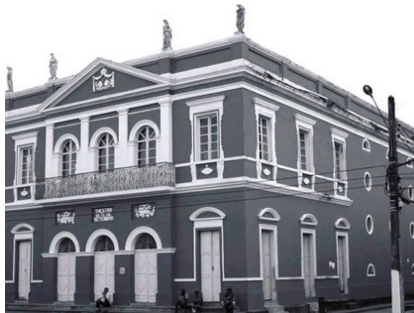
Figura 12 – Frontispício e fachada lateral sul com janelas, portas com tímpano cimbrado e óculos circulares e semicirculares
