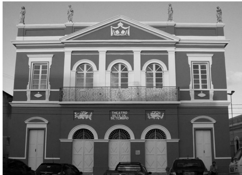
Figura 10 – Arcos sobre arcos, maciços e pilastras do Teatro Sete de Setembro
