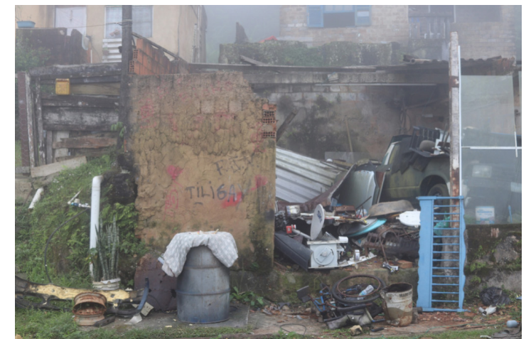
Figura 4 – Entulhos em casas no Vila Felipe
