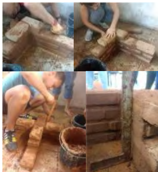
Figura 4 - Produção de alvenarias, com blocos de terra comprimida, pelos alunos disciplina Tópicos em Tecnologia da Construção (2018).
