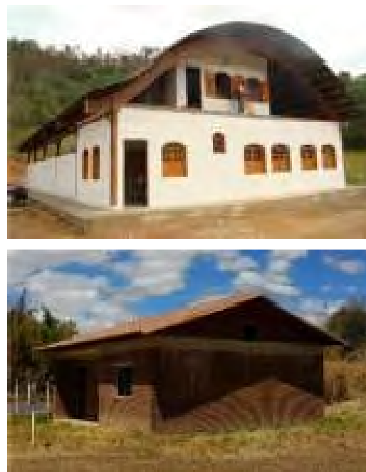
Figura 1 - Galpão de atividades de pesquisa (esq.) e casa construída com blocos de rejeito-cimento (dir.).
