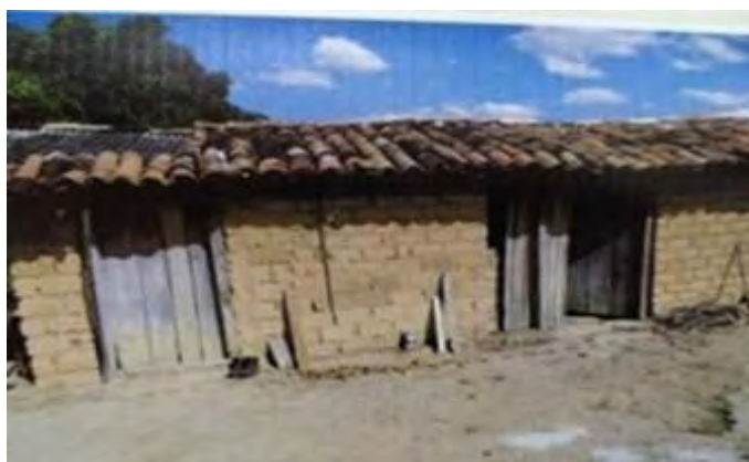
Figura 4 – Construção de casa de adobão na Comunidade dos Teixeiras.
